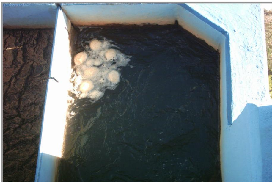
**Figura 6.3.3.3-4 – Término do processo de floculação, indo para decantação**
