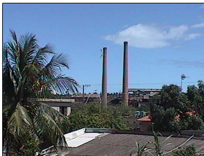
Figura 5.3.1.2-6: Usina de Carapebus.
