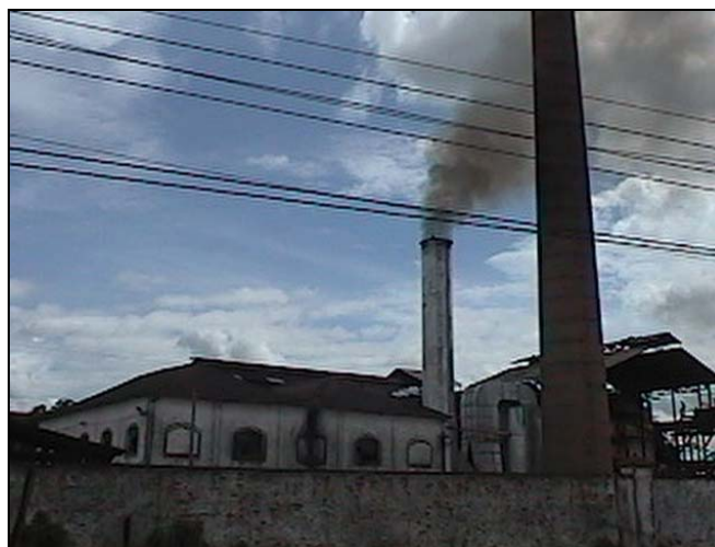
Figura 5.3.1.2-7: Usina de açúcar de Barcelos, em São João da Barra.
