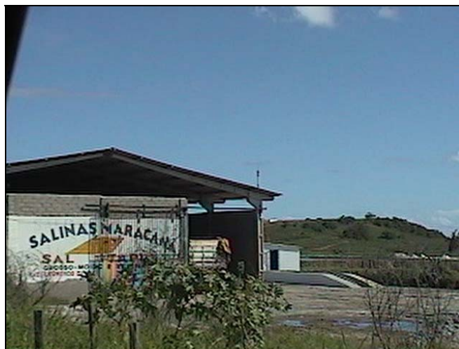
Figura 5.3.1.2-2: Salinas entre Cabo Frio e Arraial do Cabo.
