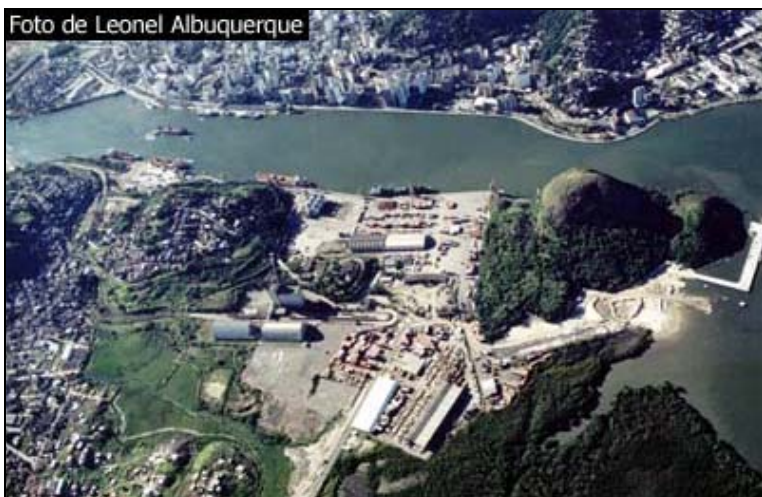
Figura 5.3.1.1-4: Porto de Vitória (Retro-área de Vila Velha) Destaque para CPVV e Cais de Capuaba.
