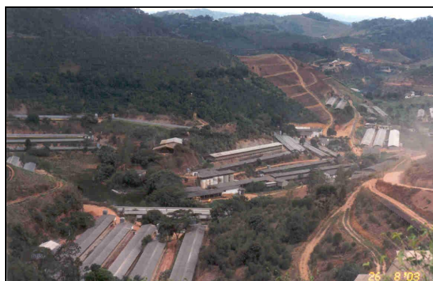
4.2.3.1.7 – Área com existência de avicultura, drenagem de rio.
