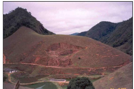
Figura 4.1.3.2.6 - Grande escorregamento próximo à tomada d'água.
