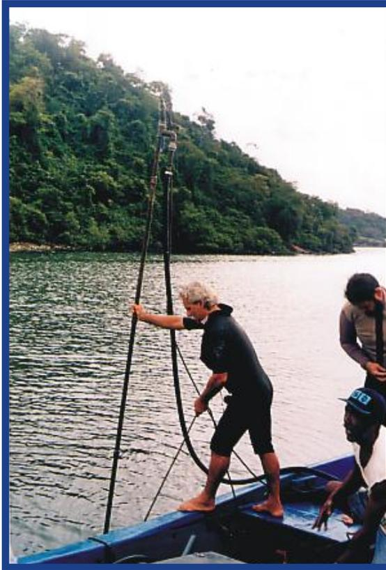
Foto 6 – Sondagem “Jet Probe”. Fase de execução dos serviços
