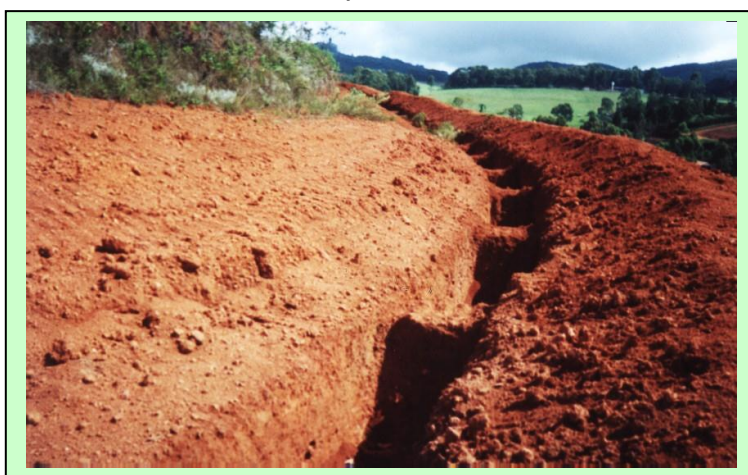
Foto 2.2 - Modelo de canal de decantação utilizado pela Mineração Curimbaba no Município de Poços de Caldas, Estado de Minas Gerais.
