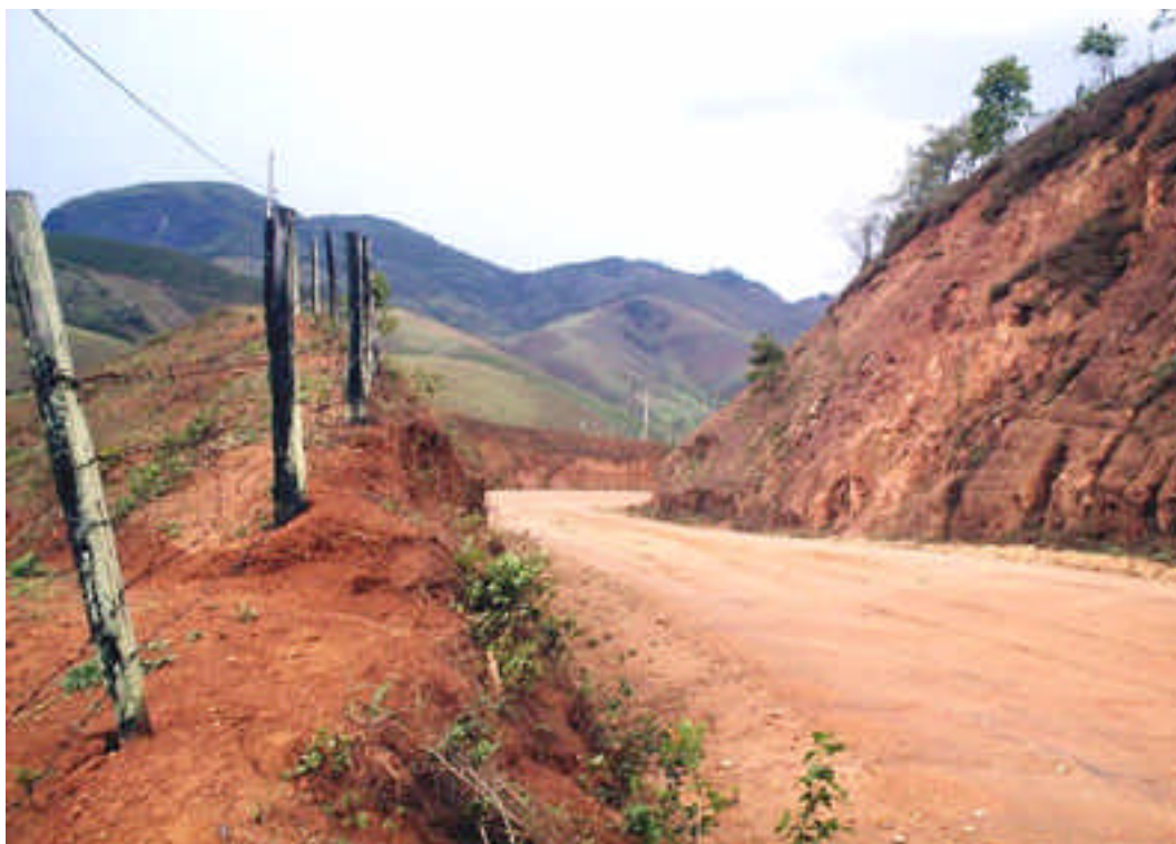
FOTO 07 – Trecho da estrada vicinal Calheiros-Rosal na altura do eixo da barragem. Nos taludes de corte aparece o solo coluvial-residual. Ao fundo aspectos do relevo de morros e partes do relevo mais íngreme formando a umas das serras da região.
