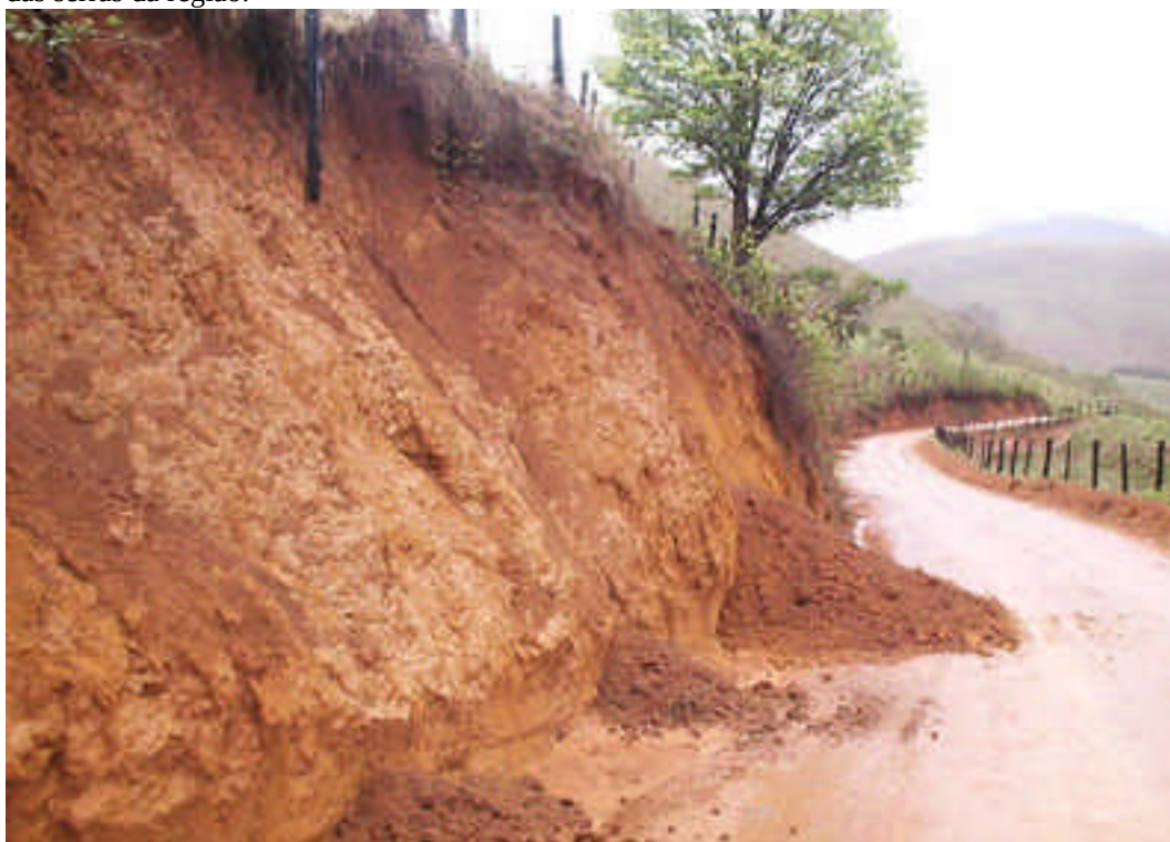
FOTO 08 – Aspectos de pequenos desbarrancamentos que se desenvolvem nos taludes dos cortes das estradas vicinais. É indicada a implantação de proteção com enrocamento, nos trechos dos taludes das estradas a serem inundados prevenindo o desencadeamento e o desenvolvimento de processos erosivos mais acentuados.
