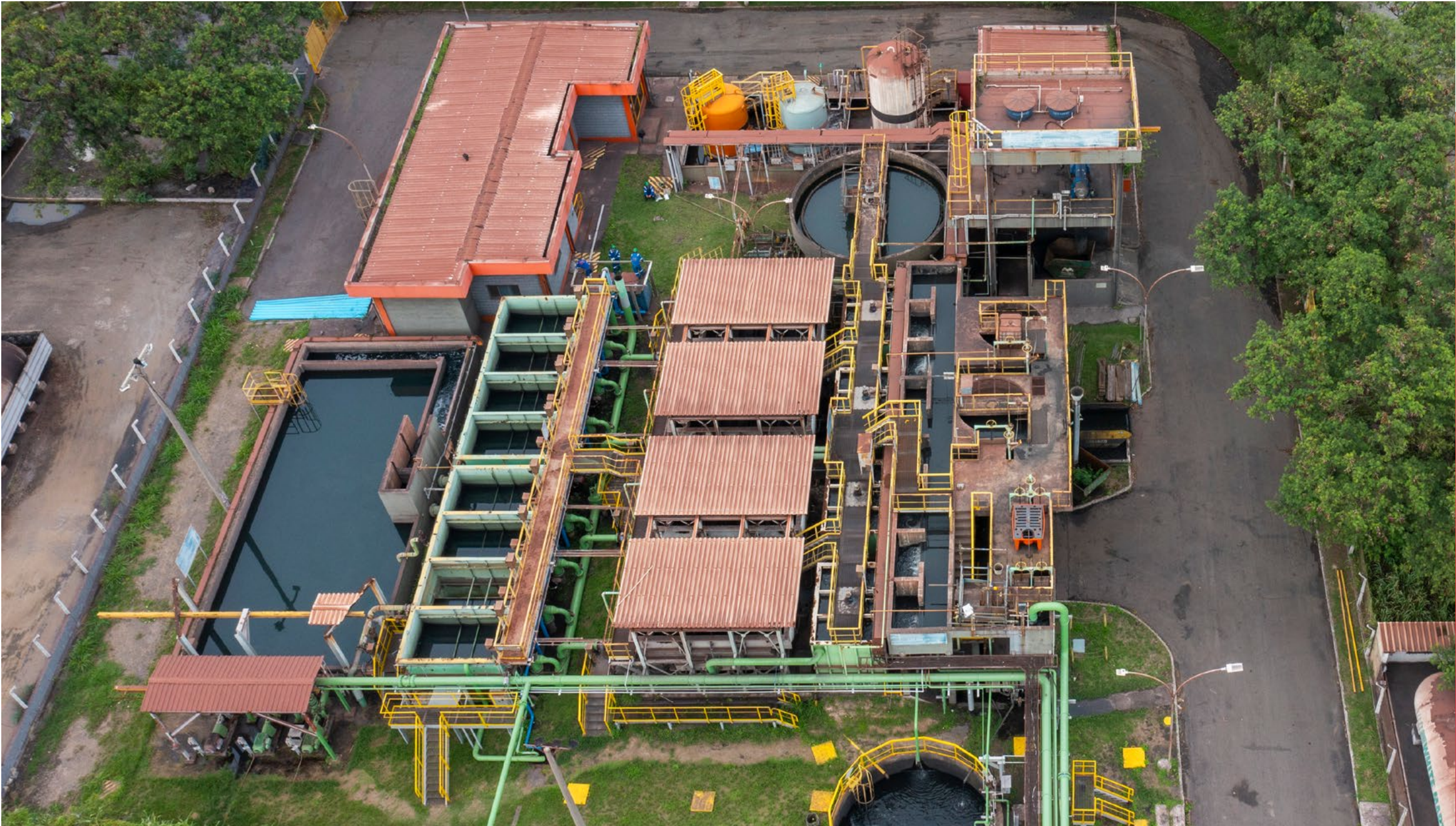
Estação de tratamento de água de reúso
