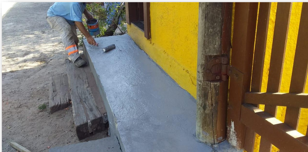
Figura 3 - Execução de pintura e recuperação de calçadas, telhados e paredes no PEPCV.
