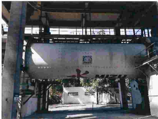
Figura 13 – Moinho de cimento
