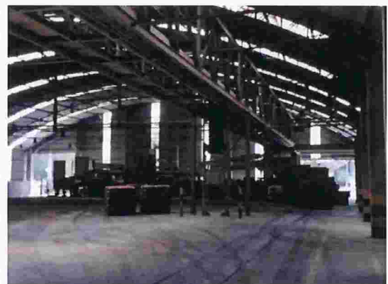
Figura 18 – Área de expedição com depósito de particulado no piso
