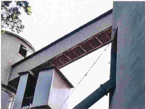
Figura 3 – Correia transportadora provida de cobertura e contenção lateral e sem bandejamento (provida de grade)
