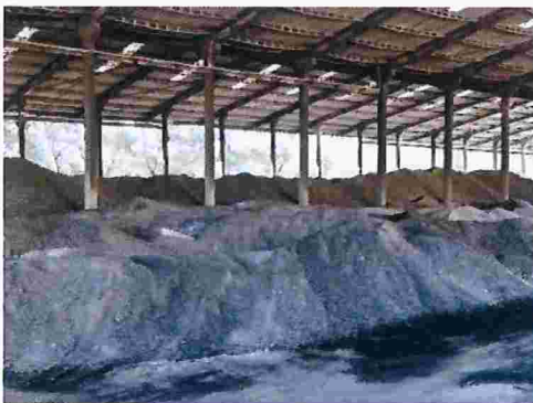
Figura 5 – Interior do galpão de armazenamento de materiais
