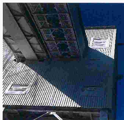
Figura 16 – Cobertura superior e contenção lateral das correias, com grade na parte inferior e depósito de material na estrutura externa.
