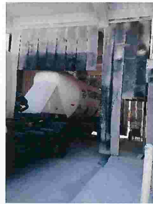
Figura 12 – Carregamento de caminhões provido de cortina de borracha na entrada e na saída, porém com acúmulo de pó no piso.
